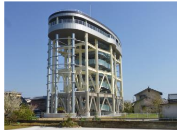
(高知県黒潮町、写真/時事) 高さ22m、収容人数230人と日本最大級の津波避難タワー
